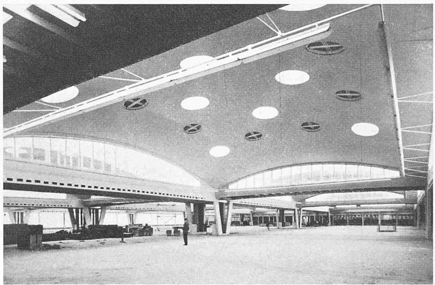
Bild 17. Wolldeckenfabrik Zoepprit in Mergelstetten (Deutschland), 1953. Länge 96 m, Breite 48 m. Zwölf einseitig eingespannte und vorgespannte zylindrische Shedschalen: Spannweite 21 m, Breite 7,50 m, Vorspannung der oberen und unteren Ränder durch gekrümmte Leoba-Spannglieder des Systems Baur-Leonhardt, 4 Kabel im oberen Rand, Spannkraft 100 t, 8 Kabel im unteren Rand als Rinnenträger, Spannkraft 200 t, Schalen in einem mittleren vorgespannten Kastenträger 350/380 cm von 36,20 m Spannweite mit 9,90 m Auskragung eingespannt. Die einzigen Stützen in dieser Halle sind die 2 Liftschächte in der Mitte. Entwurf der Tragkonstruktion: Bureau Dr. Leonhardt, und Mitarbeiter Ing. W. Pieckert, Stuttgart. Ausführung: Bauunternehmung Karl Kübler, Stuttgart
