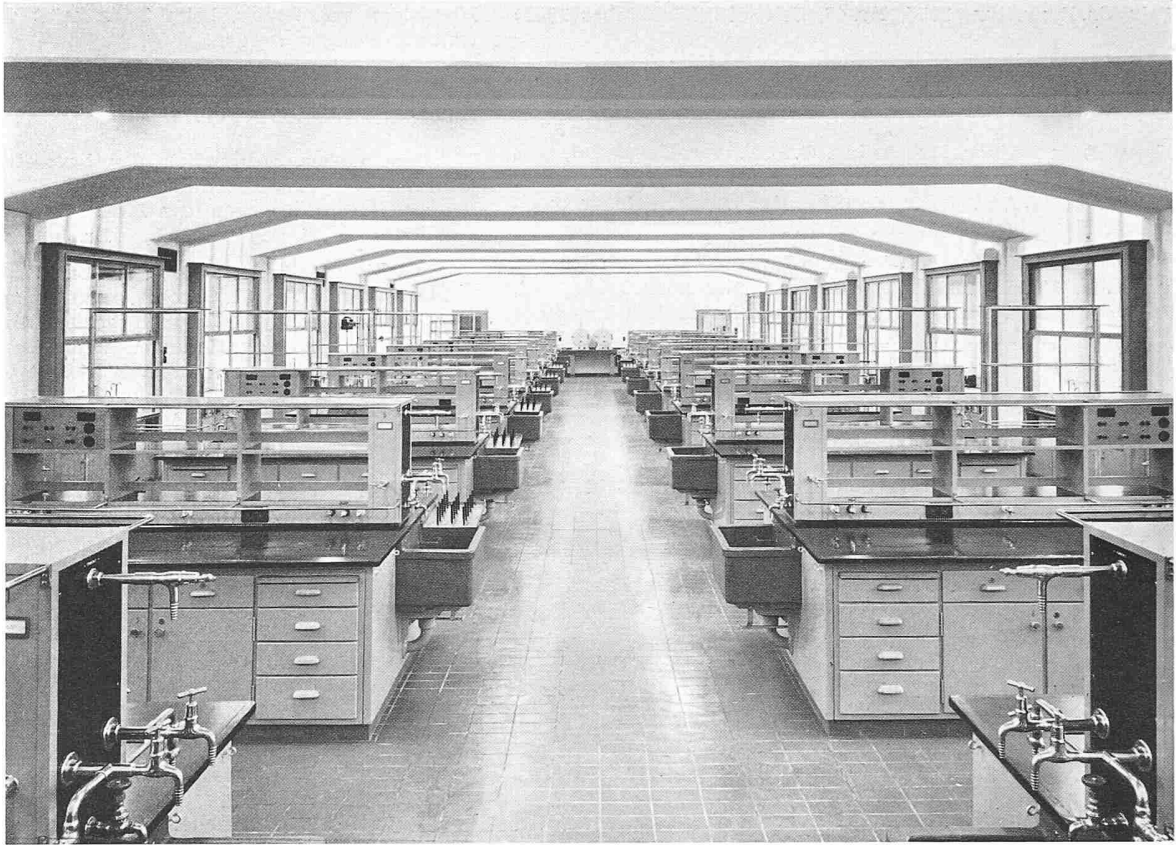
Neubau Chemiegebäude, Diplomandensaal
