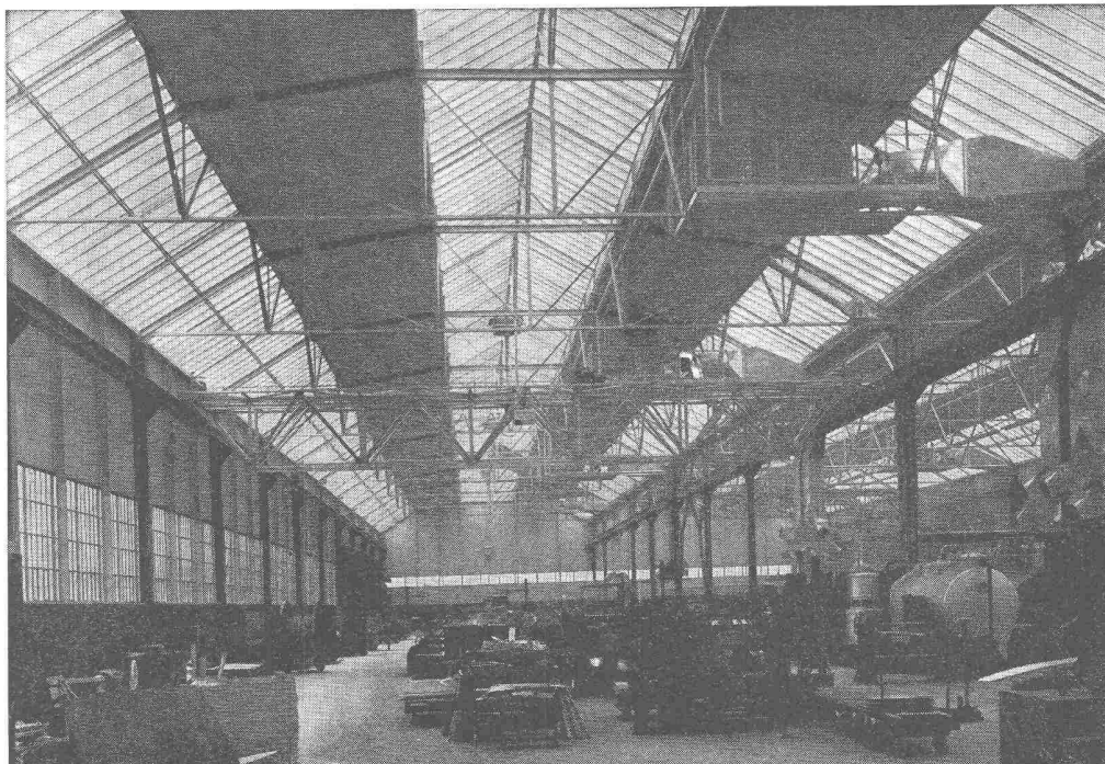
Produktionshalle, Krangerüst in Leichtmetall
