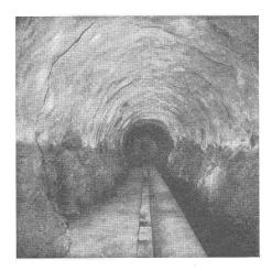
Zementputze und Beton im **Spritzverfahren** mit schnellbindendem PROGUNIT.
