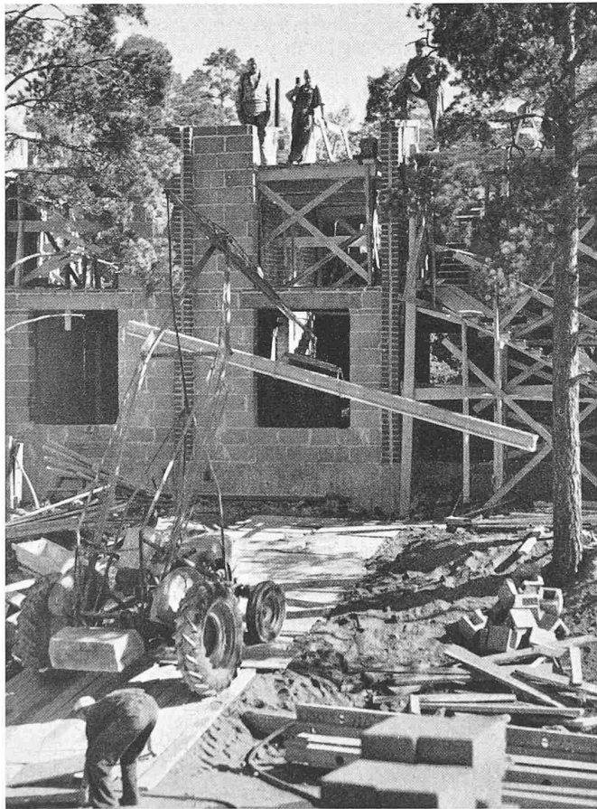
Fig. 12 et 13. Transport des éléments préfabriqués par le tracteur-grue
