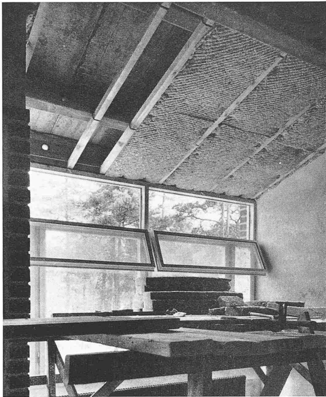
Fig. 15. Isolation sous la toiture
