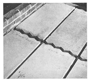
Fig. 9. Dalles posées sur les poutrelles
