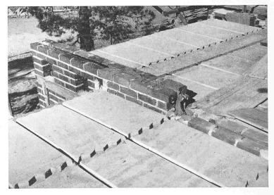
Fig. 10. Mur mitoyen double, en briques
