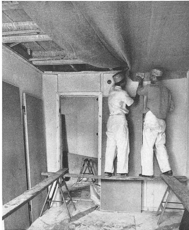
Fig. 16. Confection du plafond en toile de jute
