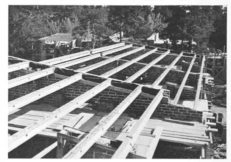
Fig. 11. Poutraison de la toiture, portée 7 m
