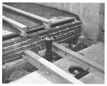
Fig. 8. Poutrelles préfabriquées système ERGE
