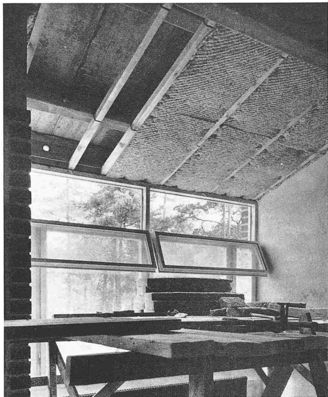
Fig. 15. Isolation sous la toiture
