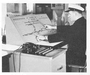
Bild 5. Domino-Stellwerk für den Bahnhof Noertzange, Luxembuorg, das auf einem Schreibpult aufgebaut ist
