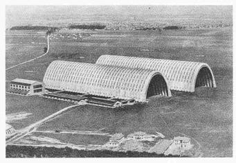
Bild 1. Flugschiffhangar in Orly bei Paris, 1921. Vierzig U-förmige Bogenrippen von 7,50 m Breite mit 80 m Spannweite, Pfeilhöhe 56 m, Gesamtlänge 300 m, auf dem Boden gelagert. Entwurf: E. Freyssinet, Paris. Ausführung: Entreprises Limousin, Paris. Zerstört im Zweiten Weltkrieg
