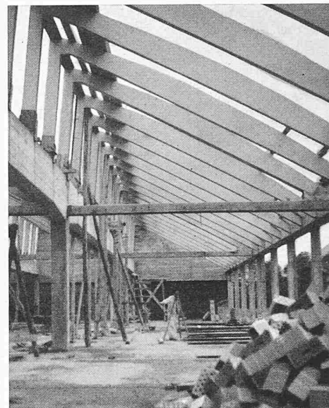
Bild 8 (rechts). Zweigfabrik der Bally Schuhfabriken AG. in Schattordorf (Uri), 1954. Shedhalle über einem Grundriss von 48,40×43,50 m mit 16,0 m Spannweite aus vorfabrizierten Betonfertigelementen, Rinnen-träger von 16 m Spannweite und 95 cm Höhe auf Hallenboden fabriziert und teilweise durch Kabel aus Drähten \varnothing 5 des Systems BBRV vorgespannt, hochgehoben als einfacher Balken unter Eigengewicht und zusammengekoppelt durch Vorspannung, so dass für Eigengewicht der Shedrahmen + Dachhaut und Nutzlast durchlaufende Balken über 3 Feldern entstehen, Spannkraft 130 t, Shedrahmen 12 cm breit mit 7,20 m Spannweite und 2,75 m Höhe aus Stahlbeton. Entwurf der Tragkonstruktion: Studienbureau der Bauunternehmung Rothpletz, Lienhard & Cie. AG., Aarau. Ausführung: Bauunternehmung Imholz, Schattordorf
