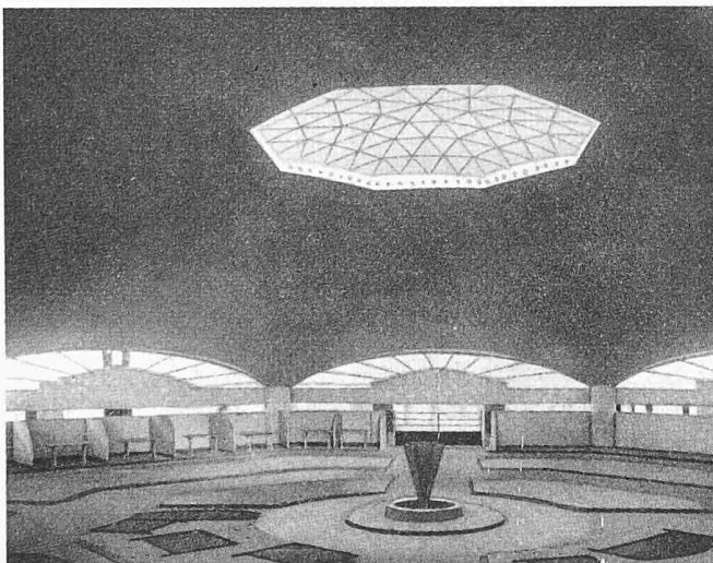
Bild 3. Markthalle in Algeciras (Spanien), 1932. Schalenkuppel von 47,62 m Spannweite mit vorgespanntem Zugband, aufgelagert auf 8 Säulen, Krümmungsradius 44,10 m, Schalendicke 9 cm, Scheitelöffnung mit 9 m Durchmesser. Entwurf: Prof. Dr. h. c. E. Torroja, Madrid. Ausführung: D. R. Barredo, Madrid
