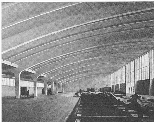
Bild 14. Ausstellungshalle 5 in München, 1953. Halle: Länge 120,68 m, Breite 40 m. Zylindrische Schale von 30 m Breite, Krümmungsradius 75 m, mit Hauptbindern alle 10 m, 30 m Spannweite und 10 m Ausladung. Die Binder wie auch die Randecken der Schale in der Diagonalrichtung sind durch das System Dywidag mit Stäben \varnothing 26 vorgespannt. Entwurf der Tragkonstruktion: Studienbureau Dyckerhoff & Widmann KG., München. Ausführung: Bauunternehmung Dyckerhoff & Widmann KG., München.
