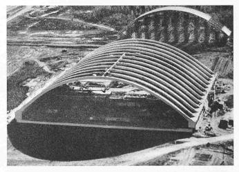
Bild 13. Flugzeughalle in Rapid City, South Dakota (USA), 1950. Zylindrische Schalengewölbe von 103,70 m Spannweite und 96 m Länge, bestehend aus 13 Bogenrippen in Abständen von 7,60 m, Pfeilhöhe 22,50 m, Breite 61 cm, Höhe im Kämpfer 215 cm, im Scheitel 152 cm, Schale 12,7 cm dick, Höhe über Boden im Scheitel 27,40 m. Ausführung in 6 Abschnitten von 15,2 m auf verschiebbarem Lehrgerüst. Entwurf der Tragkonstruktion: MM. Roberts and Schaefer Company, beratende Ingenieure, Chicago
