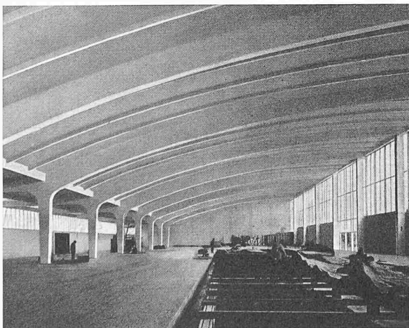
Bild 14. Ausstellungshalle 5 in München, 1953. Halle: Länge 120,68 m, Breite 40 m. Zylindrische Schale von 30 m Breite, Krümmungsradius 75 m, mit Hauptbindern alle 10 m, 30 m Spannweite und 10 m Ausladung. Die Binder wie auch die Randecken der Schale in der Diagonalrichtung sind durch das System Dywidag mit Stäben \varnothing 26 vorgespannt. Entwurf der Tragkonstruktion: Studienbureau Dyckerhoff & Widmann KG., München. Ausführung: Bauunternehmung Dyckerhoff & Widmann KG., München.
