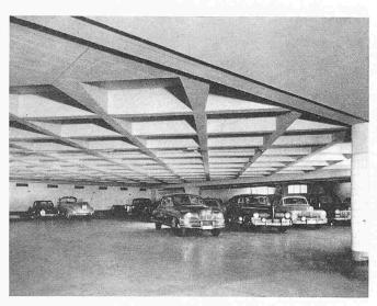
Bild 5. Garagedecke des Geschäftshauses «Bärenhof», Zürich, 1948. Schrägrostdecke über annähernd rechteckigem Grundriss  $22 \times 24$  m für eine Nutzlast von 400 kg/m², bestehend aus Massivplatte 10 cm, Rippen 28/70 (einschl. Massivplatte 10 cm) im Abstand von 2,07 m. Entwurf: Bureau P. Soutter, Zürich. Ausführung: Gemeinschaftsunternehmung H. Hatt-Haller AG, und Brunner & Co., Zürich
