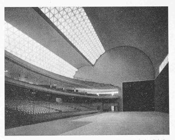
Bild 4. Fronton Recoletos in Madrid, 1936. Kreiszylindrische Schalen von 55 m Spannweite und 32,5 m Breite, Schalendicke 8 cm. Die Leitlinien sind zwei sich senkrecht zueinander schneidende Kreise mit 22,20 bzw. 6,40 m Radius. Unterbrechung der Schale für Belichtung durch dreieckförmige Zellen. Entwurf: Prof. Dr. h. c. E. Torroja, Madrid. Ausführung: Huarte y Compania S. L., Madrid. Zerstört 1939
