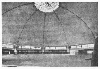
Bild 2. Markthalle in Basel, 1929. Vieleckkuppel bestehend aus 8 Abschnitten kreiszylindrischer Schalen mit Rippen, ausgeführt in Form von Klostergewölben auf 8 Stützen aufgelagert. Spannweite 60 m, Höhe 27 m, Schalendicke 8,5 bis 10 cm. Entwurf: Studienbureau Dyckerhoff & Widmann KG., Deutschland. Ausführung: Ed. Züblin & Co. AG., Basel
