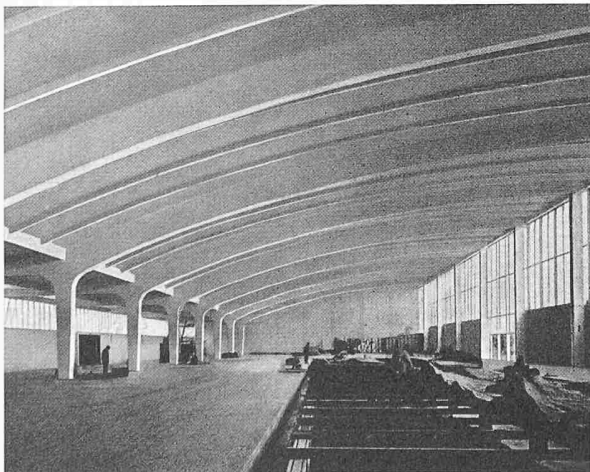
Bild 14. Ausstellungshalle 5 in München, 1953. Halle: Länge 120,68 m, Breite 40 m. Zylindrische Schale von 30 m Breite, Krümmungsradius 75 m, mit Hauptbindern alle 10 m, 30 m Spannweite und 10 m Ausladung. Die Binder wie auch die Randecken der Schale in der Diagonalrichtung sind durch das System Dywidag mit Stäben \varnothing 26 vorgespannt. Entwurf der Tragkonstruktion: Studienbureau Dyckerhoff & Widmann KG., München. Ausführung: Bauunternehmung Dyckerhoff & Widmann KG., München.
