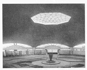
Bild 3. Markthalle in Algeciras (Spanien), 1932, Schalenkuppel von 47,62 m Spannweite mit vorgespanntem Zugband, aufgelagert auf 8 Säulen, Krümmungsradius 44,10 m, Schalendicke 9 cm, Scheitelöffnung mit 9 m Durchmesser, Entwurf: Prof. Dr. h. c. E. Torroja, Madrid. Ausführung: D. R. Barredo, Madrid
