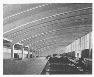
Bild 14. Ausstellungshalle 5 in München, 1953. Halle: Länge 120,68 m, Breite 40 m. Zylindrische Schale von 30 m Breite, Krümmungsradius 75 m, mit Hauptbindern alle 10 m, 30 m Spannweite und 10 m Ausladung. Die Binder wie auch die Randecken der Schale in der Diagonalrichtung sind durch das System Dywidag mit Stäben  $\emptyset$  26 vorgespannt. Entwurf der Tragkonstruktion: Studienbureau Dyckerhoff & Widmann KG., München. Ausführung: Bauunternehmung Dyckerhoff & Widmann KG., München.
