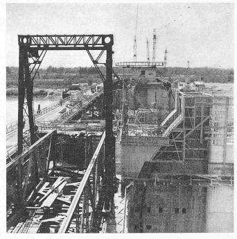
Bild 9. Stauwehr Donzère, Schalung des Pfeileraufbaues
