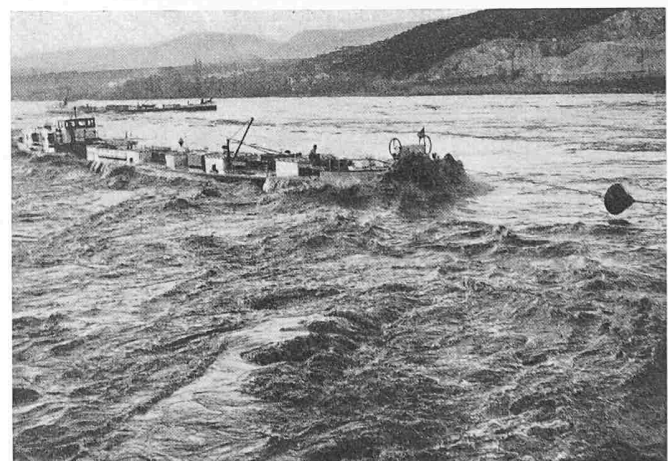
Bild 12. Stauwehr Donzère, Durchschleppen eines Tankers durch eine Öffnung bei einem mittleren Hochwasser (5000 m 2 )
