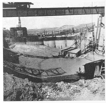
Bild 10. Abschluss der Schiffahrtsöffnung von 45 m durch Zellenfangdämme
