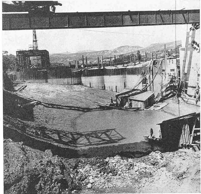
Bild 10. Abschluss der Schifffahrtsöffnung von 45 m durch Zellenfangdämme
