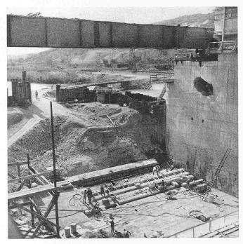
Bild 11. Stauwehr Donzère, Versetzen der Schwellenverkleidung
