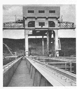
Bild 2. McNary-Stauwehr am Columbia River, USA, fahrbarer Portalkran zur Bedienung der Schützen
