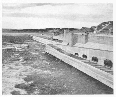
Bild 3. McNary-Stauwehr am Columbia River, USA, Fischtreppenanlage (Neigung 1:20, Kammerbreite 9.00 m)
