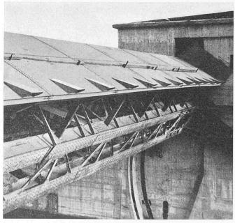
Bild 1. Stauwehr der Kraftwerkanlage Donzère-Mondragon, Segmentschütze von 45 m lichter Weite und  $9{,}15$  m Stauhöhe
