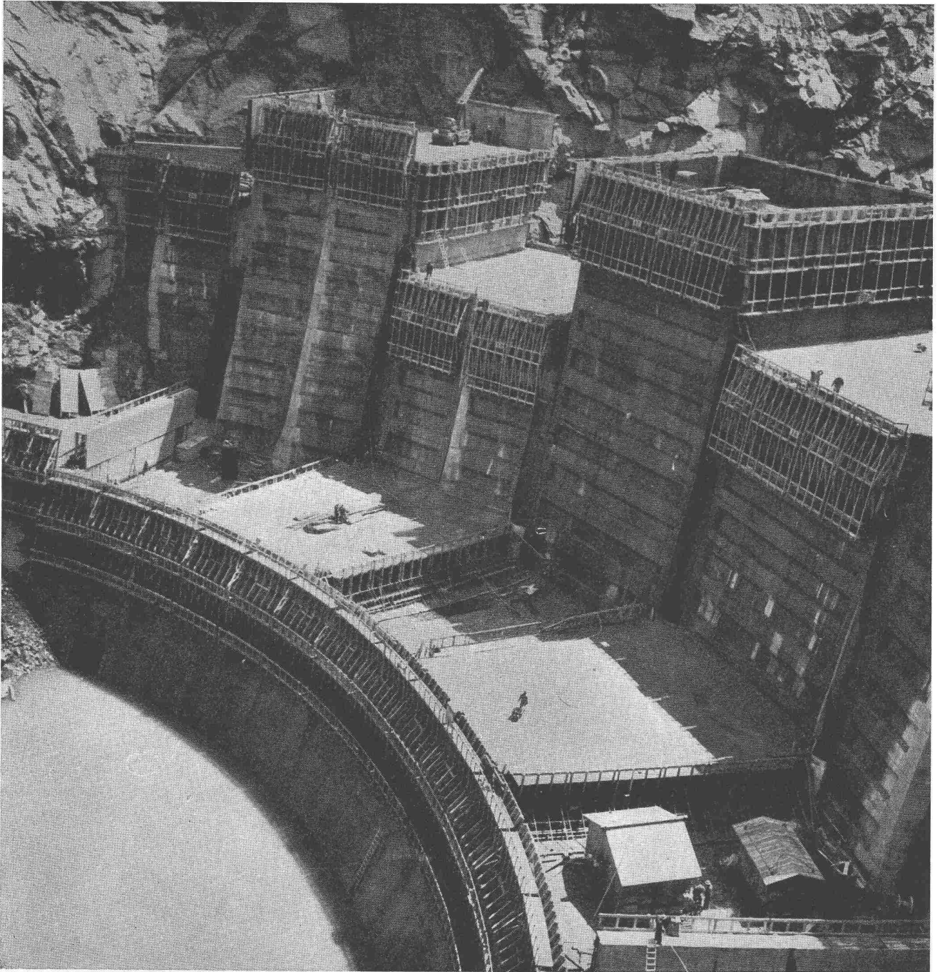
Staumauer Mauvoisin (Stand Mitte Juli 1955)
