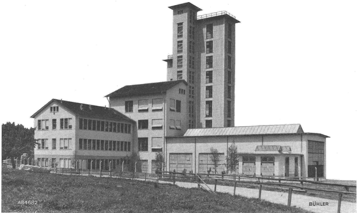
Unser Forschungs- und Versuchs-Gebäude mit Pneumatikturm
