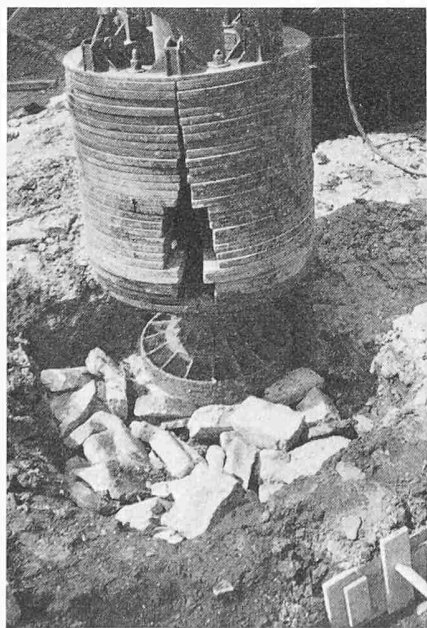
Bild 3. Aufsetzen des Mammutrüttlers auf eine Lage Grobsteine
