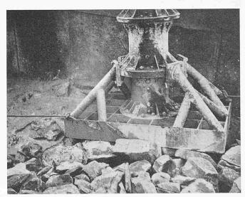
Bild 7. Einrütteln von Grobsteinen in Feinbeton (Teilansicht des Mammutrüttlers mit Rüttelkorb)
