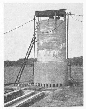
Bild 7. Tropfkörper der Anlage Bild 6
