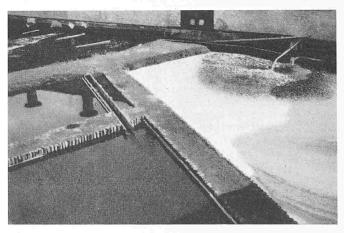
Bild 3. Versuchsanlage gemäss Bild 1, vom Tropfkörper aus gesehen: rechts das Rohabwasser, links Ausgleichbecken und Nachklärbecken
