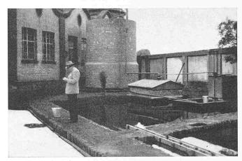
Bild 2. Versuchsanlage gemäss Bild 1: links Rohabwasser, hinten Tropfkörper, Ausgleichbecken. Pumpanlage; im Vordergrund Nachklärbecken
