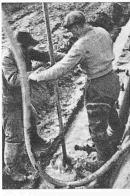
Bild 8. Ländernach-Kanal, Einspülen der Filterrohre
