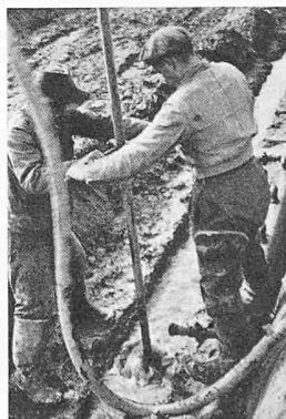
Bild 8. Ländernach-Kanal, Einspülen der Filterrohre
