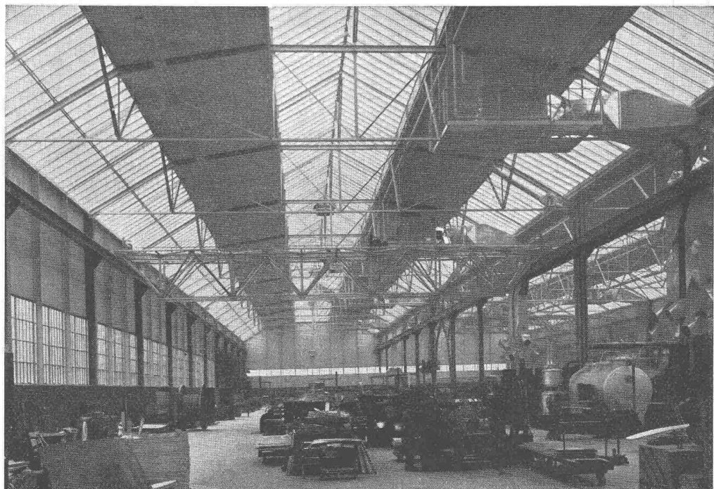
Produktionshalle, Krangerüst in Leichtmetall
