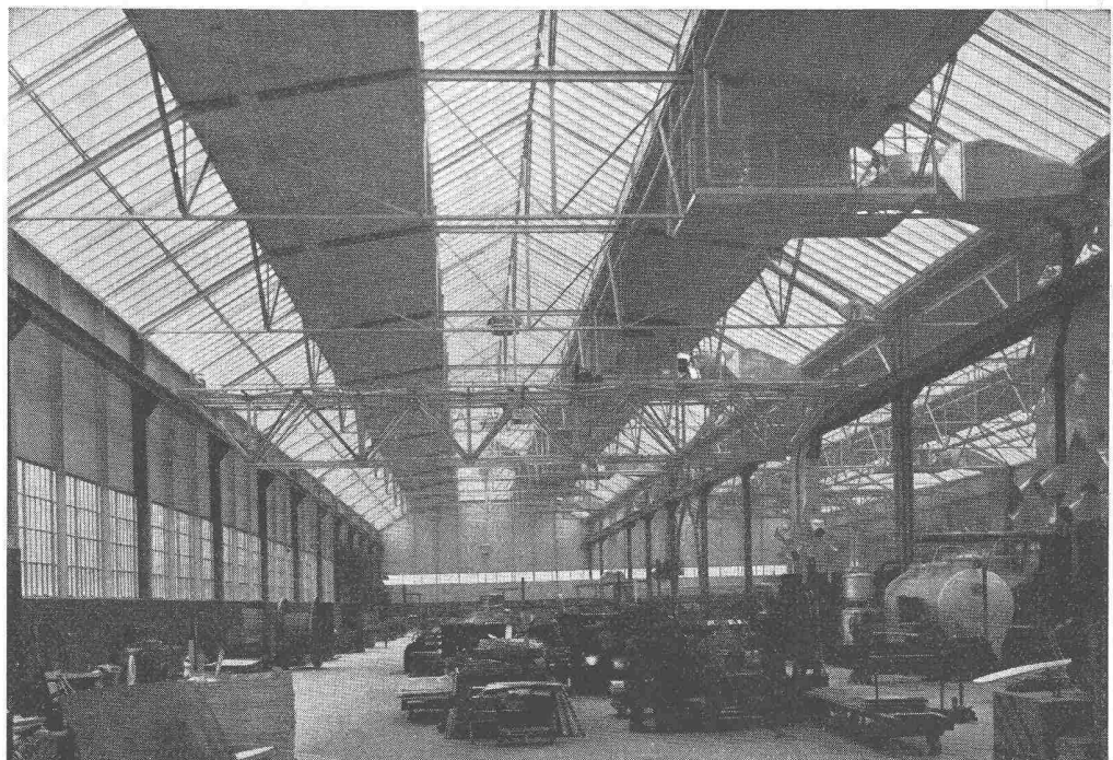
Produktionshalle, Krangerüst in Leichtmetall
