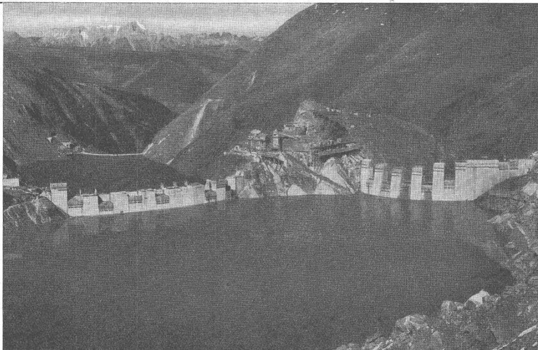
Tauernkraftwerke Kaprun-Salzburg: Mooserbodensperre und Drossensperre, erbaut in FRIOPLAST-Beton. Im Hintergrund: Limbergsperre (PLASTIMENT-Beton)
