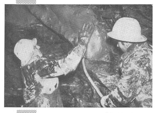
Kraftwerk Zervreila Abdichtung des Zulaufstollens mit Barra Rapid U
