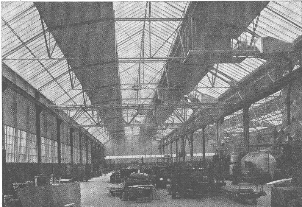
Produktionshalle, Krangerüst in Leichtmetall
