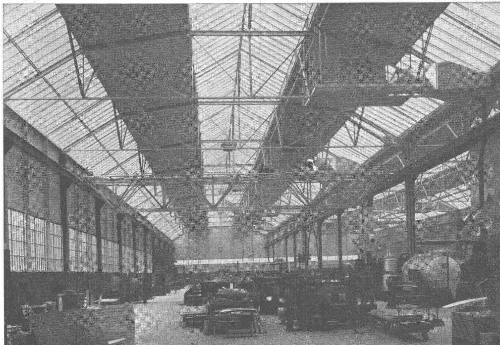
Produktionshalle, Krangerüst in Leichtmetall
