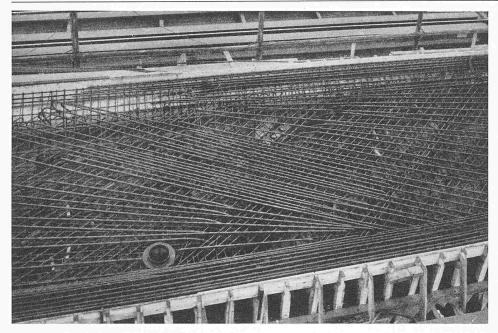
Bild 14. Einzelheiten der Armierung
