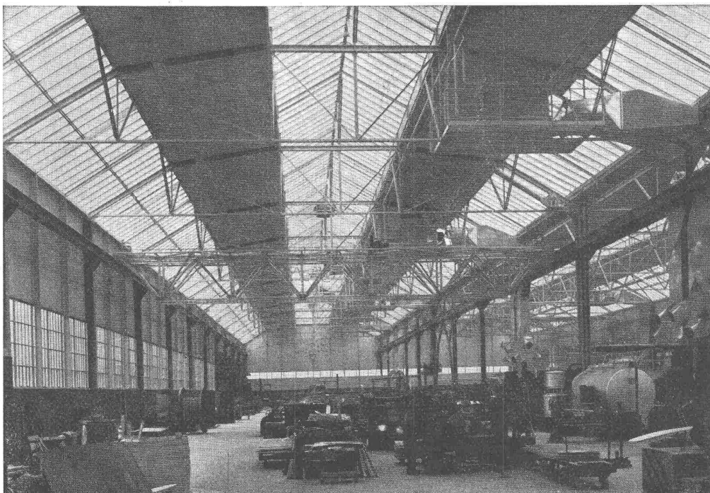
Produktionshalle, Krangerüst in Leichtmetall
