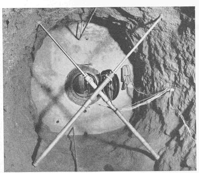
Bild 2. Wasserseite des Abpresszapfens im Fensterstollen Nascharegnas
