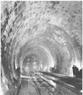
Bild 19. Verkleidung mit Betonplatten
