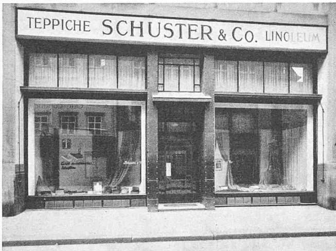
Bild 1. Fassade Multergasse vor dem Umbau
