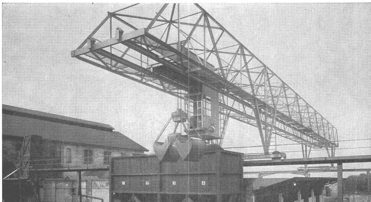
Verladebrücke in Schweisskonstruktion 2,5 t Tragkraft, 46 m Länge
