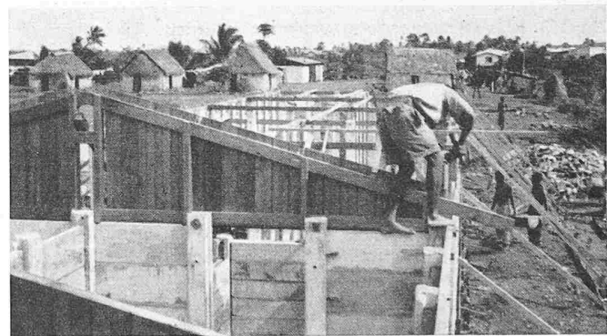
Bild 10. Befestigen der Holzbinder
