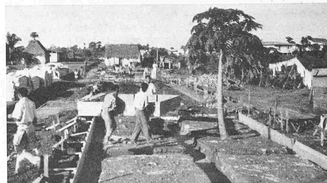
Bild 11. Vorbereitungen zum Aufstampfen der Beton-Grundplatte
