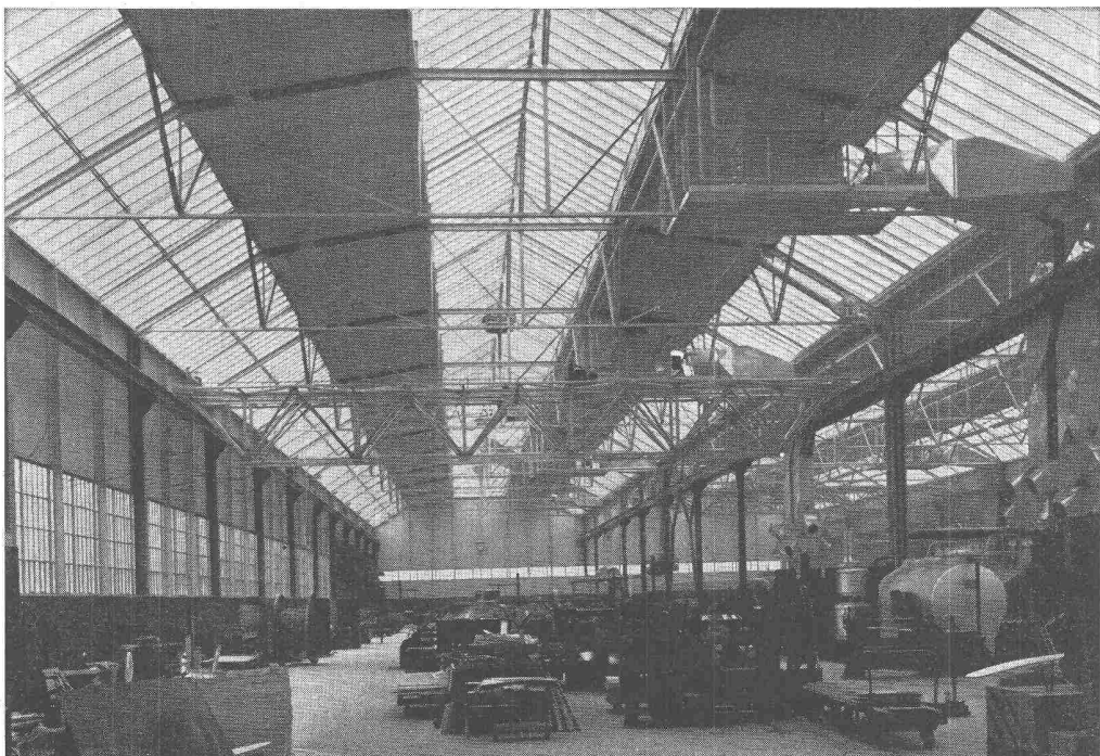
Produktionshalle, Krangerüst in Leichtmetall
