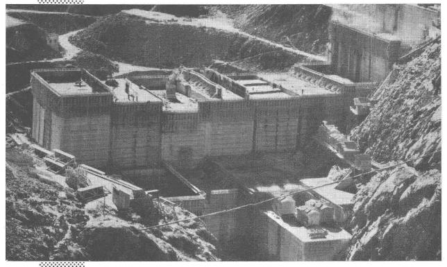
Staumauer Grande Dixence, Betonierung mit Zusatz von BARRA-55-Vinsol (1. Phase von 1 800 000 m³ Beton)
