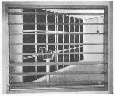
Bild 5. Frischluftklappe mit Servomotor, dahinter eine Filterbatterie
