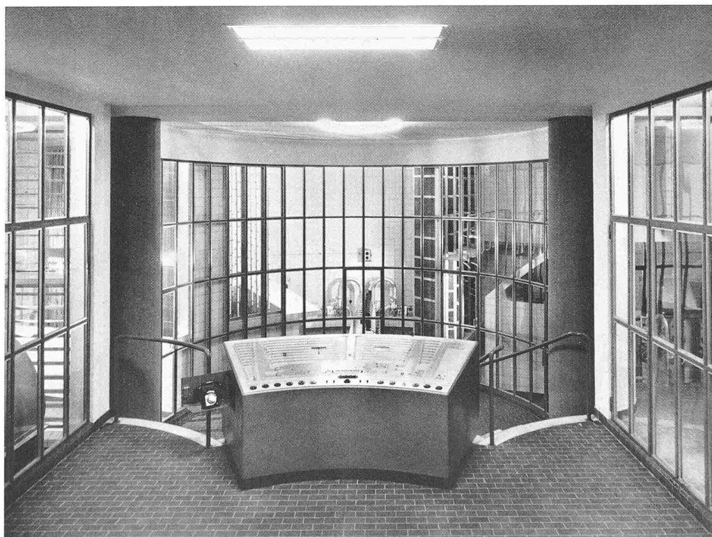
Zentrale Klimaanlage, Kommandopult
