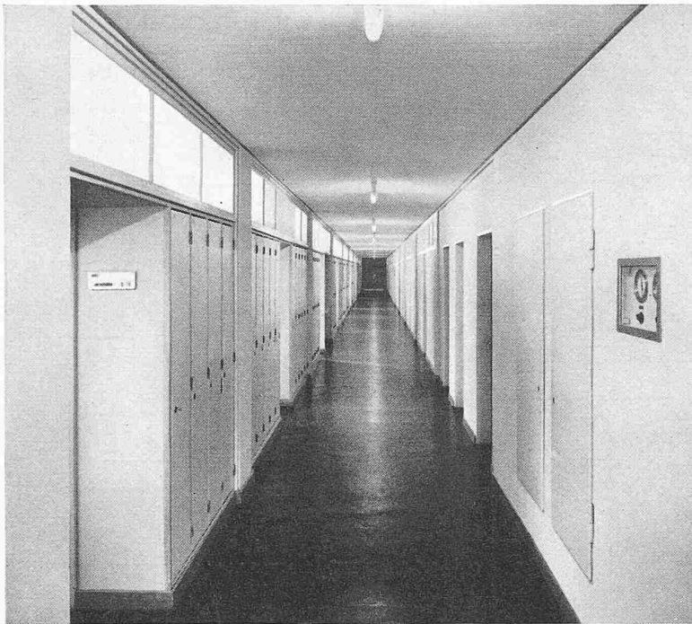
Bild 14. Korridor mit gerillter Gipsdecke, über der sich die Luftkanäle befinden; rechts vorn: Türe zur Bedienungsnische für die Unterstation, davor Instrumentenkästen
