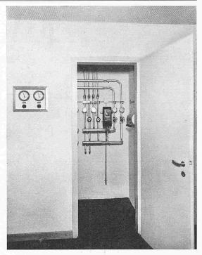
Bild 15. Blick in die Bedienungsnische einer Stockwerk-Unterstation
