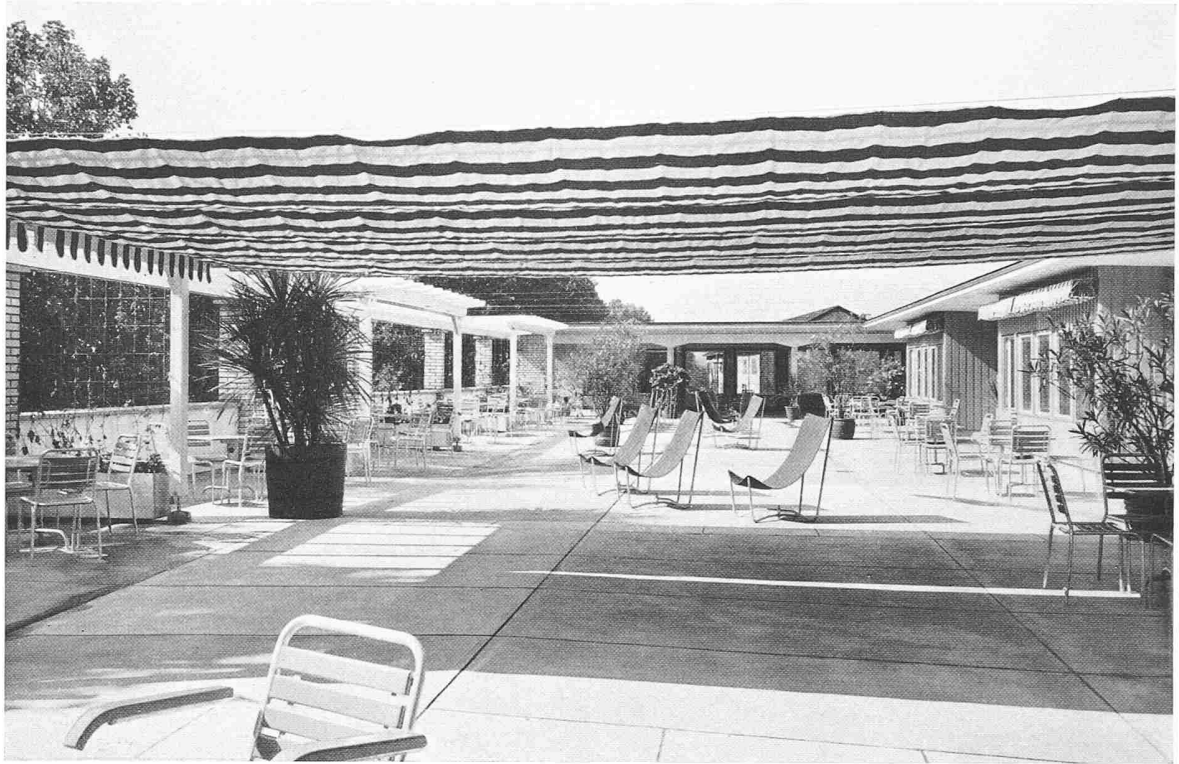
Dachterrasse des Wohlfahrtshaus
