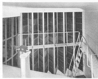
Bild 10. Mischkammer mit Blick auf Filter, im Vordergrund Rückluft-Messäule. — Statt Befeuchtungssystem lies durchwegs «Nasskonditionierungs»-System
