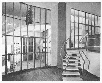
Bild 8. Klimazentrale, rechts oben Rückluftventilator, vorn das Steuerpult, links oben Rückluft-Druckkanal mit Regulierklappen, darunter Enthärtungsanlage, links unten Abwasserpumpe
