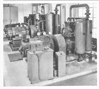
Bild 18. Die Wärmepumpenzentrale
