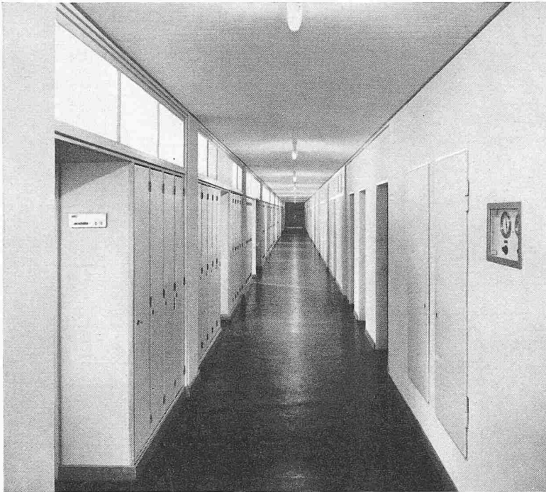
Bild 14. Korridor mit gerillter Gipsdecke, über der sich die Luftkanäle befinden; rechts vorn: Türe zur Bedienungsnische für die Unterstation, davor Instrumentenkästchen
