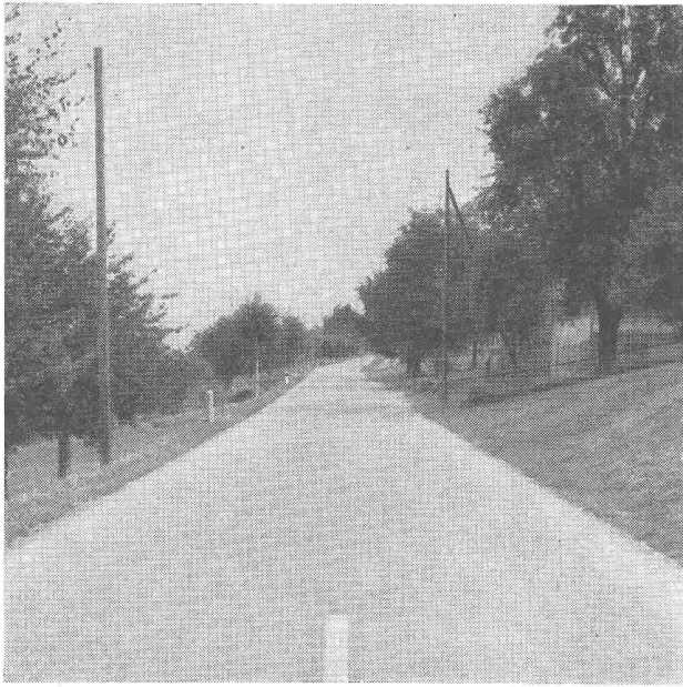
Tribollingen - CARPAVE-Belag eingebaut 1949
