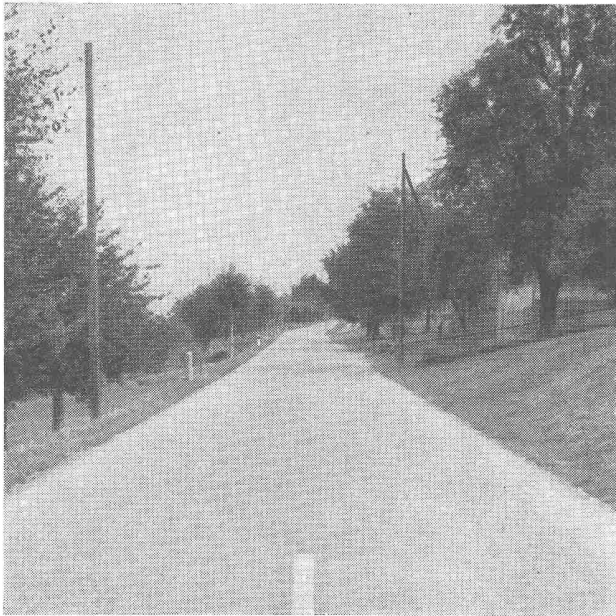
Tribollingen - CARPAVE-Belag eingebaut 1949
