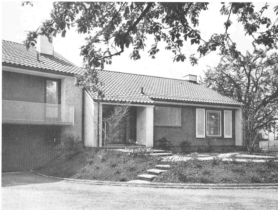
Eingangspartie aus Norden
