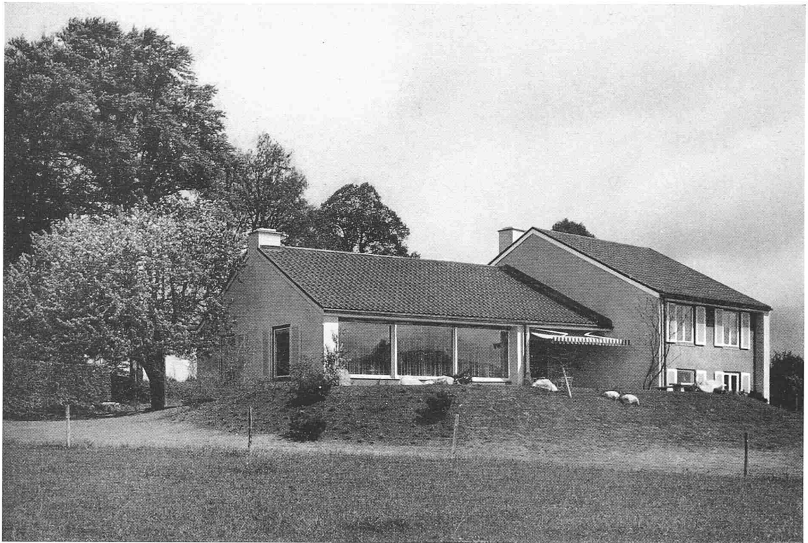
Ansicht aus Südwesten
