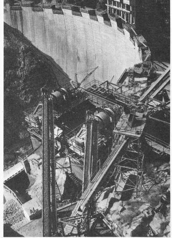
Bild 14: Wasch- und Sortieranlage mit zwei Aufgabebändern, links Hang-Silos, rechts Rückführung zur Nachkörnung
