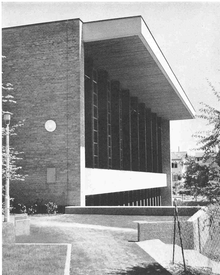
Südwestecke der Turnhalle
