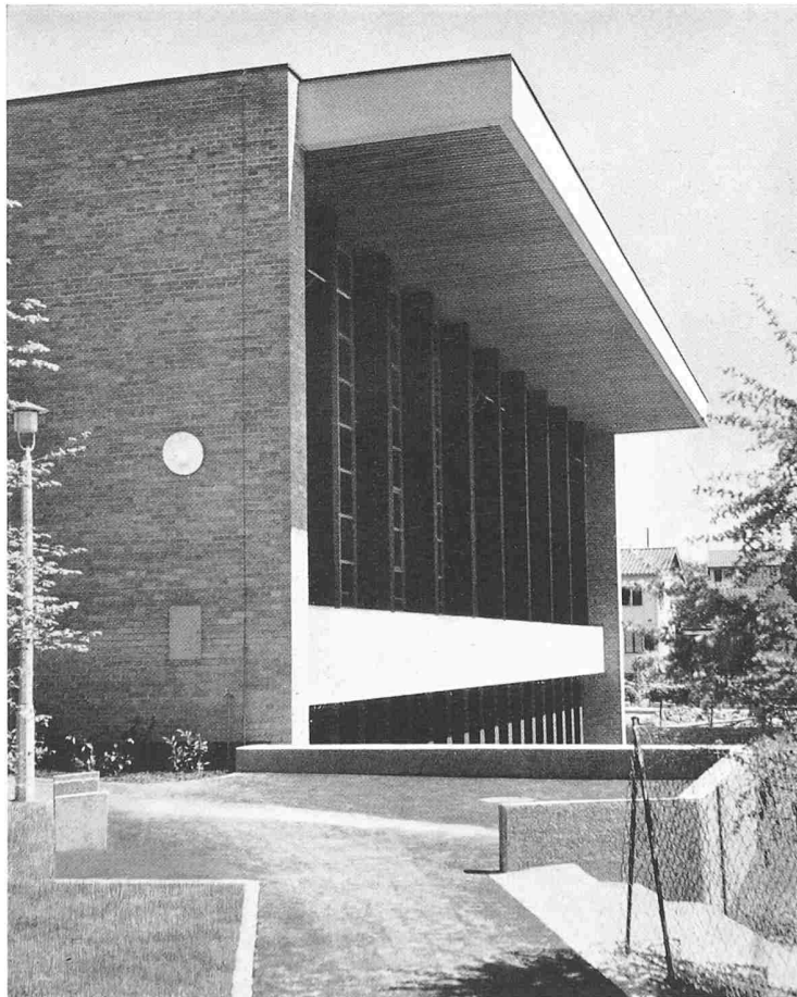
Südwestecke der Turnhalle
