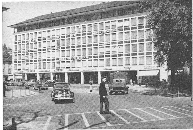
Uniongebäude, Arch. E. Häny &amp; Sohn †
