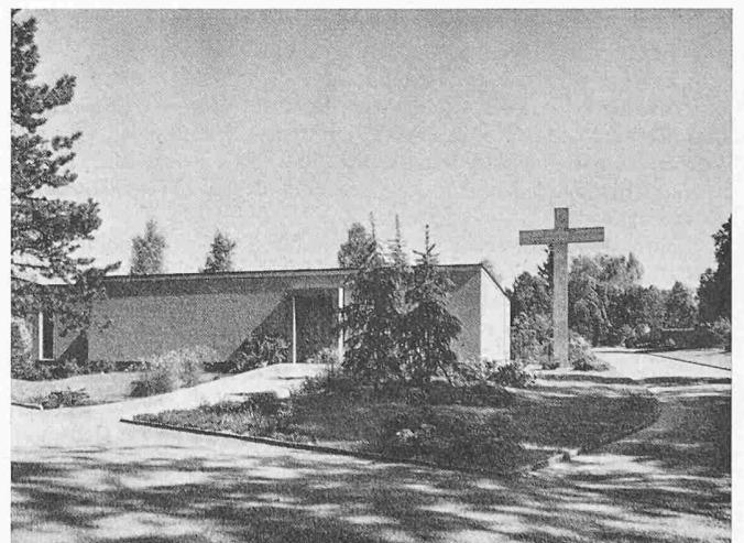
Leichenhalle Kesselhalden, Städt. Hochbauamt
