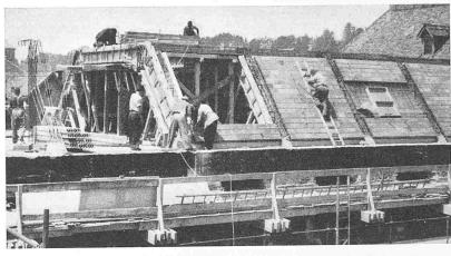
Bild 7. Einschalen der trapezförmigen Rahmen und Verlegen des Unterdaches aus Tonhohlsteinen
