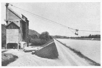
Bild 11. Kiesgewinnungsanlage der Rheinkies-AG, bei Salez. Tagesleistung  $500~\mathrm{t}$
