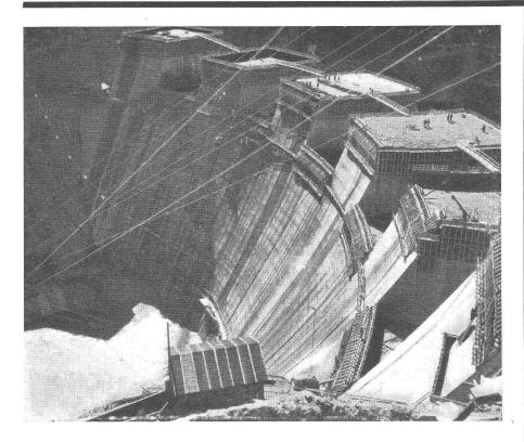
Staumauer Sambuco der Maggiakraftwerke: 2. Etappe Vorsatzbeton mit FRIOPLAST
