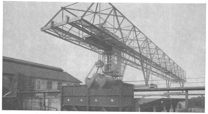
Verladebrücke in Schweisskonstruktion 2,5 t Tragkraft, 46 m Länge
