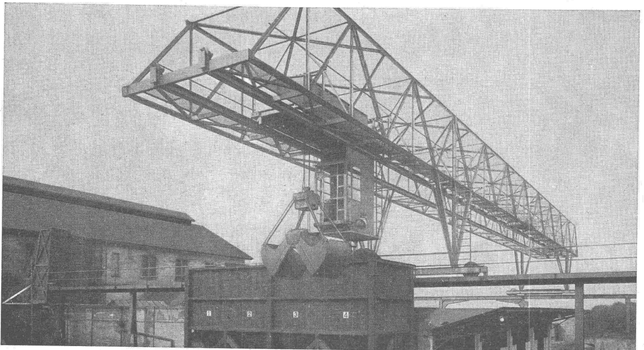
Verladebrücke in Schweisskonstruktion 2,5 t Tragkraft, 46 m Länge
