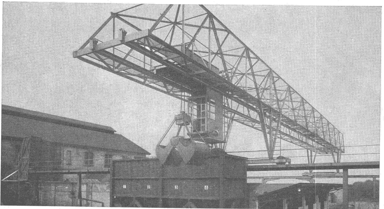
Verladebrücke in Schweisskonstruktion 2,5 t Tragkraft, 46 m Länge
