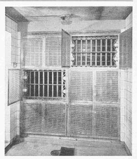
Bild 3. Sulzer-Elektrofilteranlage für eine Luftmenge von  $20\,000\,$  m³/h
