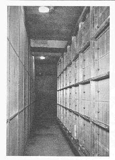
Bild 1. Sulzer-Elektrofilter für eine Leistung von 120 000  $\mathrm{m}^3/\mathrm{h}$
