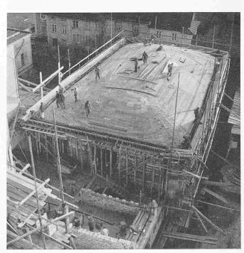
Bilder 5a und 5b. Herstellung der Schalung für den Neubau des Hotels Kreuz in Langenthal
