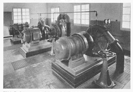
Bild 1. Bewässerungspumpwerk der Gemeinde Chamoson, ausgerüstet mit zwei Mitteldruck-Zentrifugalpumpen von 70 und 170 l/s Fördermenge bei 120 und 78 m Förderhöhe und einer Hochdruck-Zentrifugalpumpe von 60 l/s Fördermenge bei 89 m Förderhöhe
