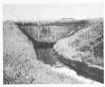
Aqueduc du Talent sur le canal oriental. Différence des plans d'eau:  $4\ \mathrm{m}.$
