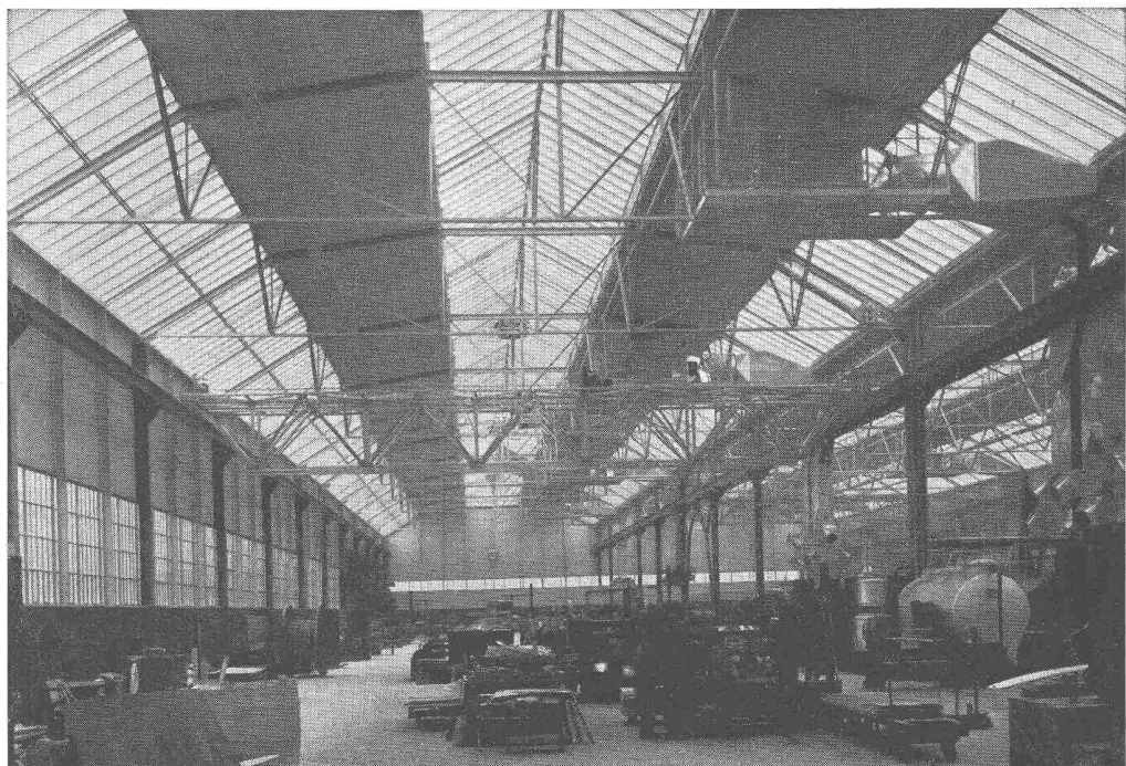
Produktionshalle, Krangerüst in Leichtmetall
