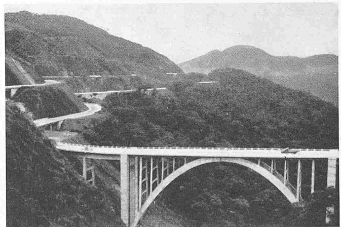
Bild 35. «Via Anchieta», Autostrasse zwischen Sao Paulo und Santos
