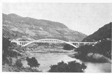
Bilder 38 und 39. Rio das Antas-Brücke, Durchblick und Seitenansicht (Spannweite 186 m)
