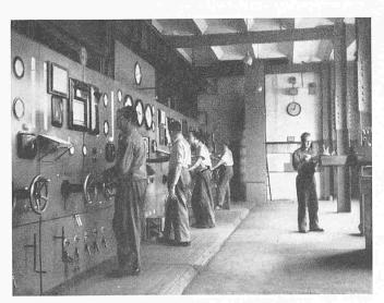
Bild 8. Zentrale Steueranlage für die Bedienung der Perkolatoren
