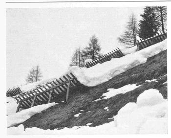
Bild 30. Auf Rechen aufgeschobene Schneeschicht. Im Vordergrund und im Hintergrund Schneeschicht bis auf Grasnarbe abgeglitten. Photo SLF, M. Schild.
