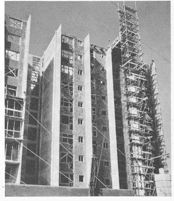
Bild 6. Die hellen Wände sind in Gleitschnellbauweise erstellt; rechts der Gerüstturm
