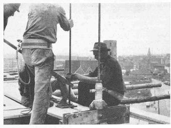
Bild 7. Demontagearbeiten an einem Hochhaus im Gleitschnellbau
