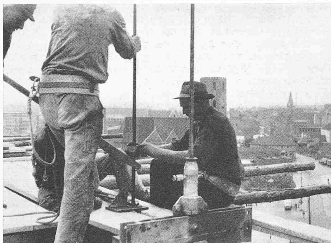
Bild 7. Demontagearbeiten an einem Hochhaus im Gleitschnellbau
