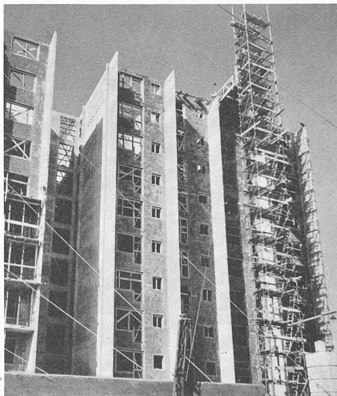
Bild 6. Die hellen Wände sind in Gleitschnellbauweise erstellt; rechts der Gerüsturm
