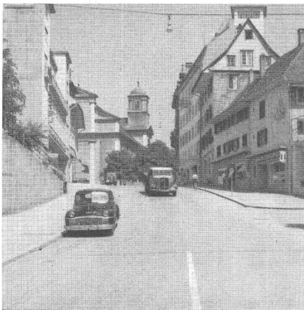
Mühlegasse Olten • Steilrampe mit Bitumen-Rauhbelag
