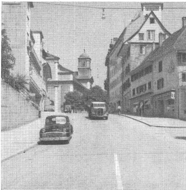
Mühlegasse Olten • Steilrampe mit Bitumen-Rauhbelag
