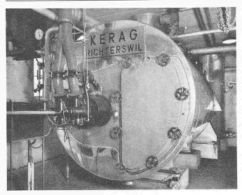
Bild 2. Ansicht des Kessels mit eingebauter Oelfeuerung
