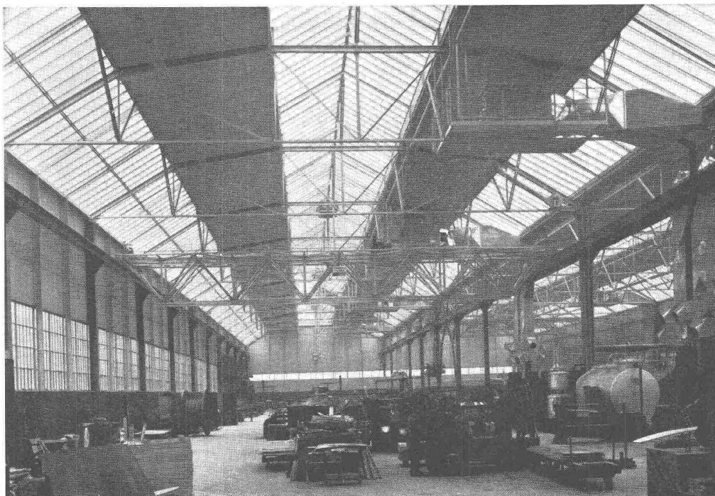
Produktionshalle, Krangerüst in Leichtmetall
