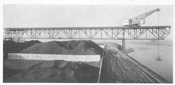
toren-Ausgleichswelle der Motoren gewährleistet. Die Brückenfahrgeschwindigkeit beträgt 25 m/min. Die Brückenbremsung wird durch Bremsdrücker und Magnet zweistufig vorgenommen, um einerseits ein sanftes Abbremsen, anderseits ein sicheres Halten der Brücke gegen heftigen Wind sicherzustellen.
