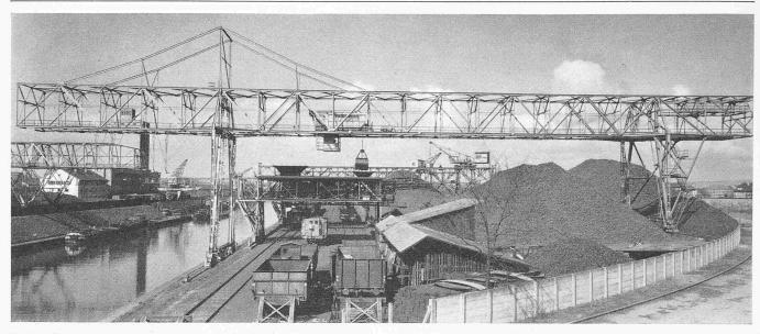
Bild 6. Verladebrücke II der Kohlenversorgungs AG., Basel, im Hafenbecken II. Spannweite 63 m, landseitiger Kragarm 15 m, wasserseitiger Kragarm 28 m, Greiferlaufkatze von 6,5 t Tragkraft
