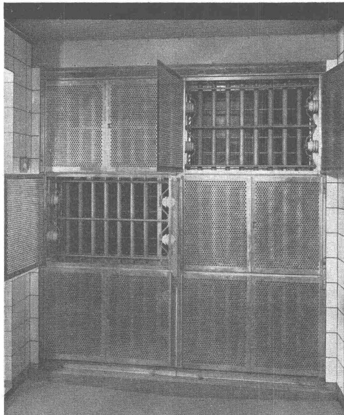
Sulzer-Elektrofilter für eine größere
