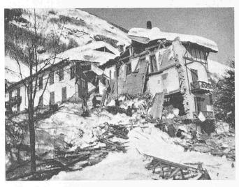
Bild 22. Haus in Vals-Platz, dessen eine Hälfte 1951 von einer Lawine scharf abgeschnitten wurde
